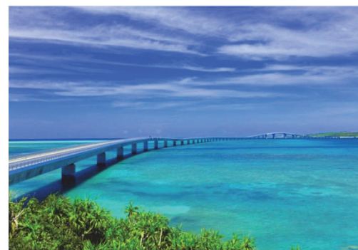
伊良部大橋（伊良部地区）
